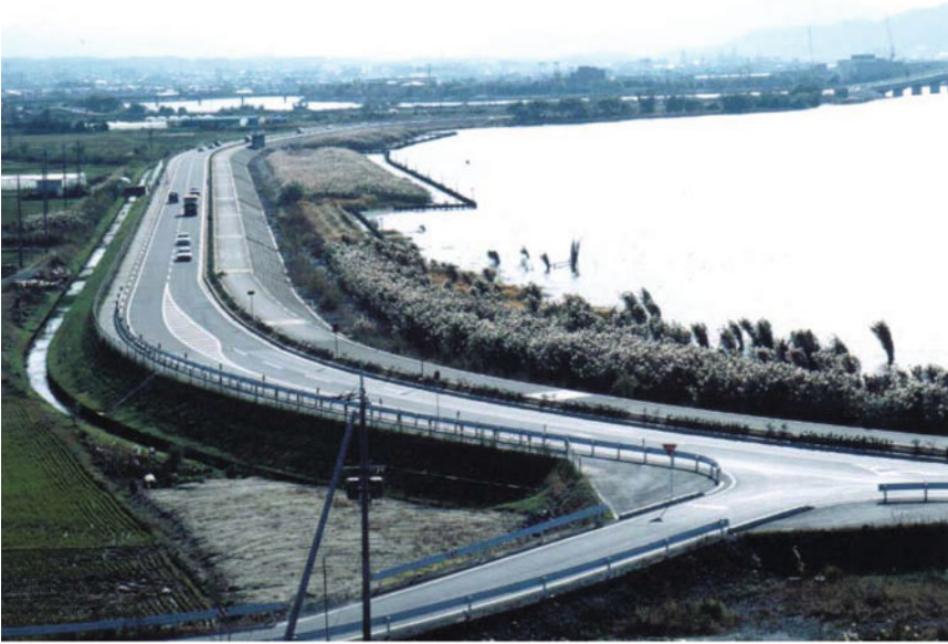
Lakeshore embankment (Kusatsu Area)
